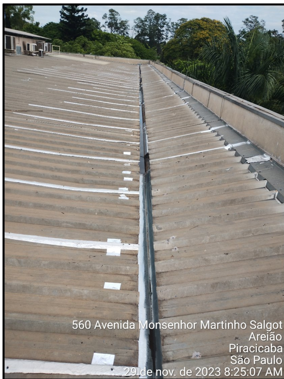
Vista da calha, rufos e pingadeira
