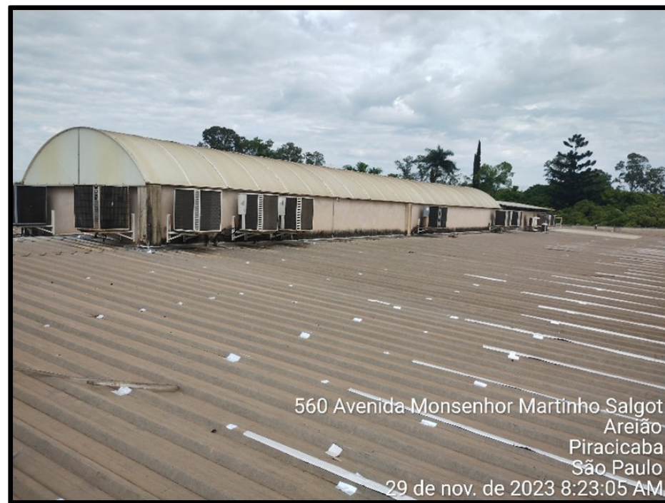
Vista do telhado
