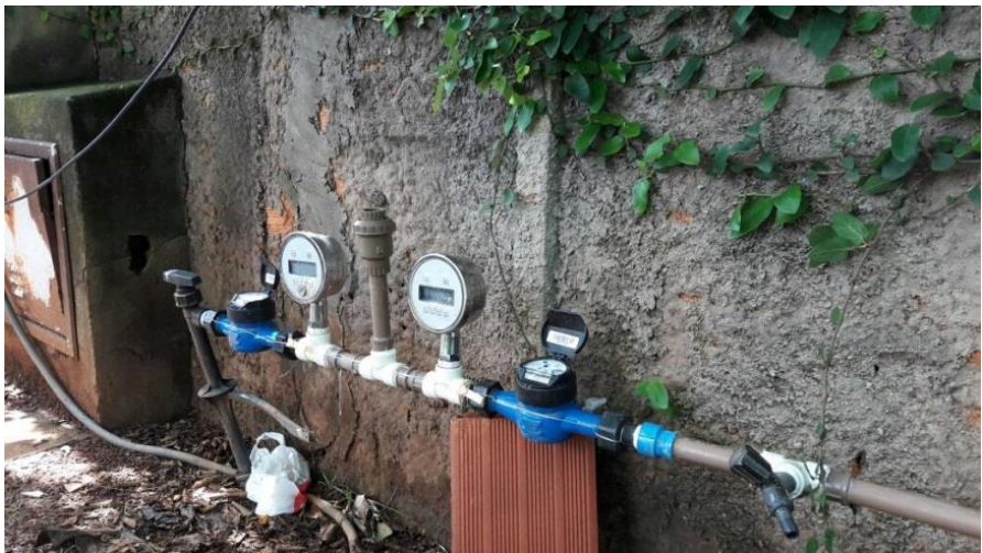
Figura 31 – Montagem do cavalete em campo com a válvula ventosa.
