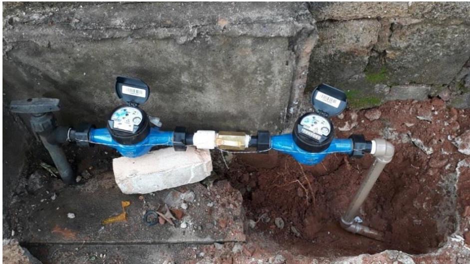
Figura 35 – Cavalete com a instalação do bloqueador de ar HG (em latão) em campo.
