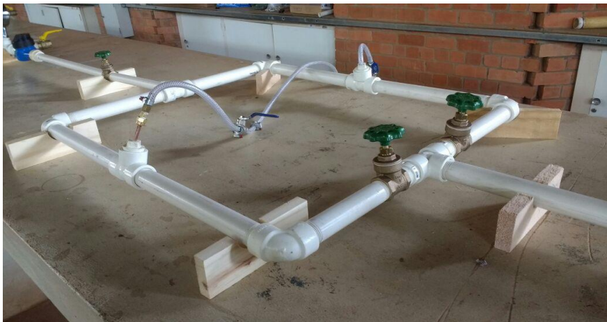
Figura 9 – Detalhe da ramificação da bancada de teste.
