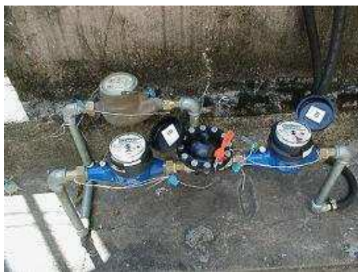
Figura 2 - Aparato de teste da COPASA.
