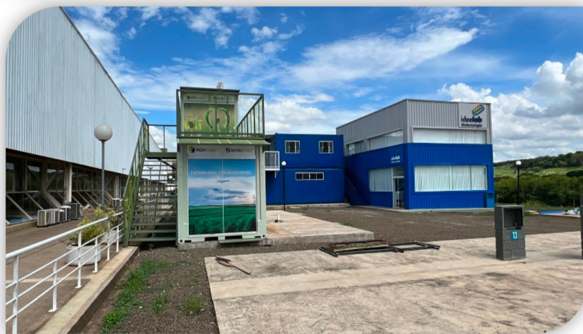
Vista do Container Park Lab no Núcleo do Parque Tecnológico de Piracicaba - 2024
