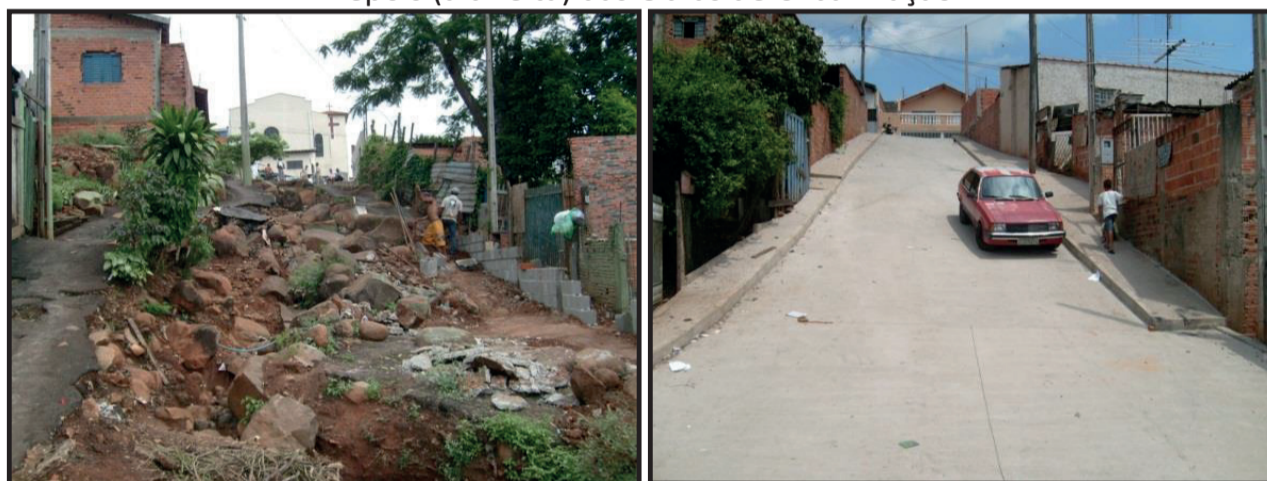
FIGURA 55 – Vistas do Jardim Monte Cristo – Antes (à esquerda) e, Depois (à direita) das Obras de Urbanização.
