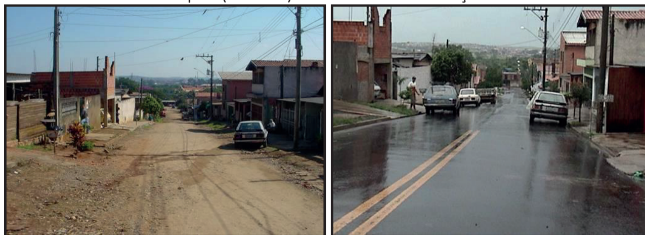
FIGURA 52 – Vistas do Jardim Algodal – Antes (à esquerda) e, Depois (à direita) das Obras de Urbanização.
