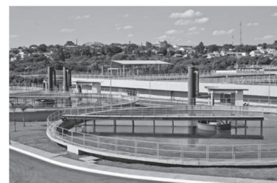
FIGURA 36 - Estação de Tratamento de Esgoto da Ponte do Caixão.
