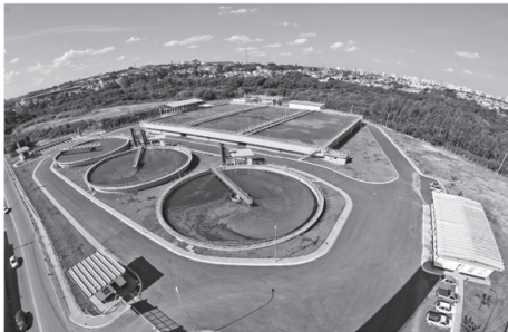
FIGURA 37 - ETE Ponte do Caixão
