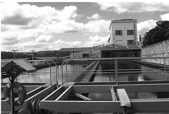
Fotografia 4 – Vista do prédio administrativo e laboratório que servem às ETA I e II
