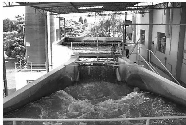
Fotografia 9 - Chegada da água bruta na Calha Parshall da ETA III
