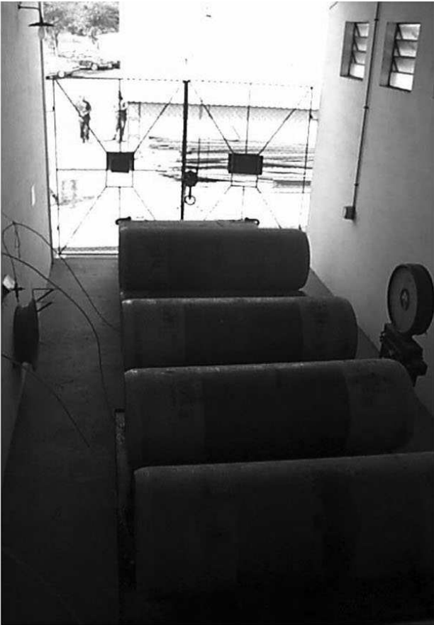
Fotografia 8 - Depósito de cilindros de cloro (900 kg) das ETAs I e II 1
