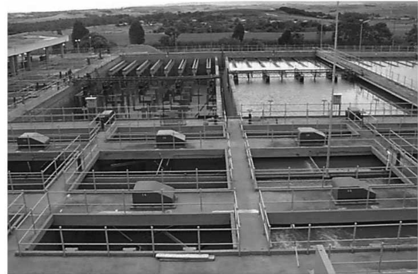
Fotografia 10 - Vista geral da ETA III, podendo-se observar parte dos floculadores, decantadores e filtros 1
