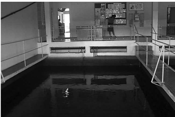
Fotografia 3 – Vista de um dos filtros da ETA I e respectiva mesa de comando 1
