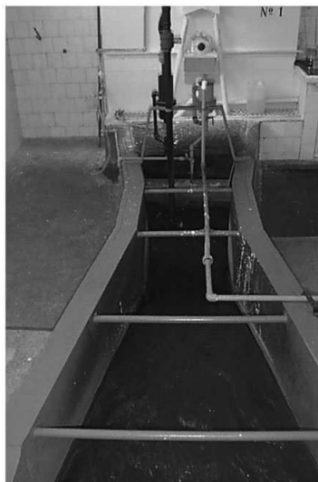
Fotografia 1 – Chegada da água bruta na ETA I, detalhe da Calha Parshall 1
