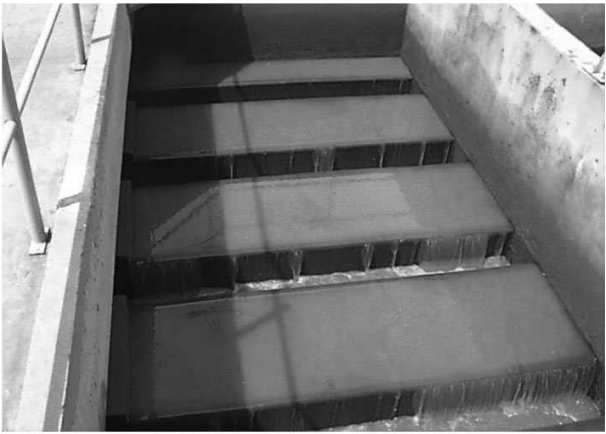
Fotografia 11 - Detalhe de um filtro durante processo de retrolavagem
