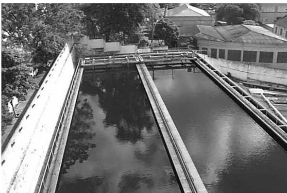
Fotografia 2 – Vista geral dos dois decantadores da ETA I, Observa-se na extremidade a parte superior dos dispositivos moveis para remoção de lodo. 1
