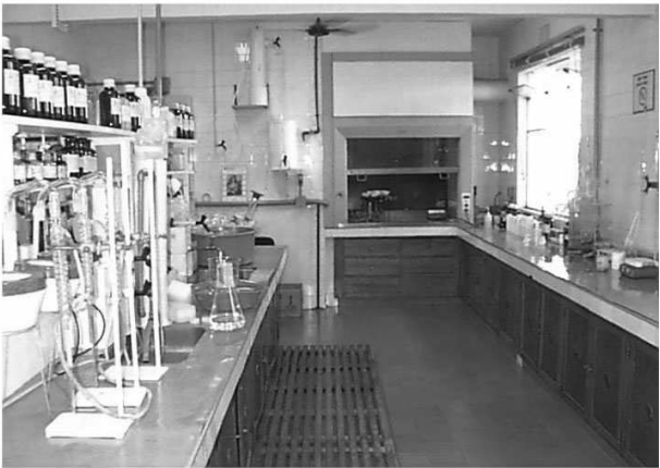
Fotografia 12 - Vista dos laboratórios da ETA III 1
