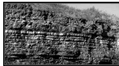
Figura 4.9. Contato entre as formações Irati, na base e Corumbatai no topo do talude, na Rodovia SP-127 (Rodovia Fausto Santomauro)
