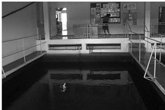
Fotografia 3 – Vista de um dos filtros da ETA I e respectiva mesa de comando<sup>1</sup>
