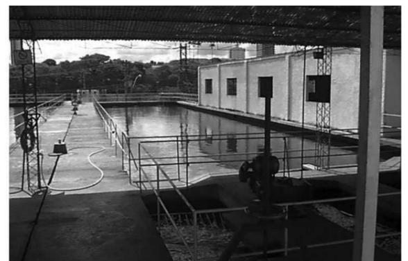
Fotografia 6 - Vista de um dos floculadores e decantadores da ETA II
