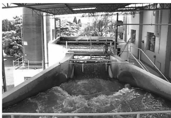
Fotografia 9 - Chegada da água bruta na Calha Parshall da ETA III
